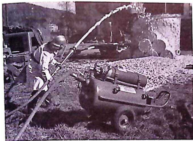
Bild 1. Tryckluftskumaggregat för skydd av oljecistern och fatlager.
