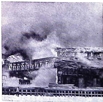
Bild 2. Brandspridningen mellan magasinerna. Bilden tagen vid B.
