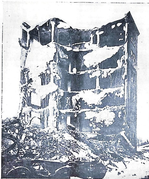
Fig. 1. Betongmagasinet efter branden.
